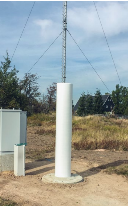
Pfeilerstation Zinnwald im Bau
