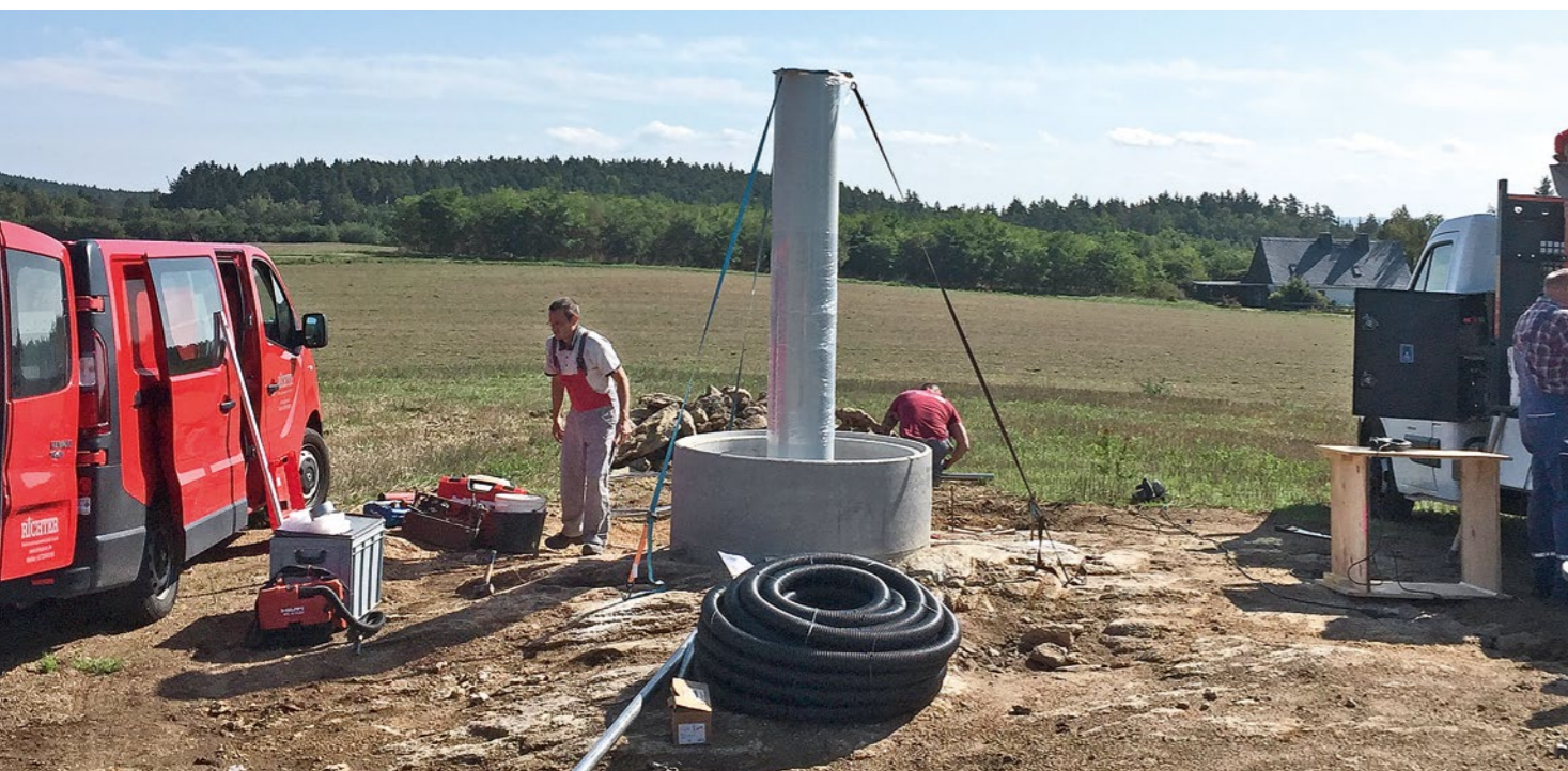
Pfeilerstation Bad Brambach im Bau
